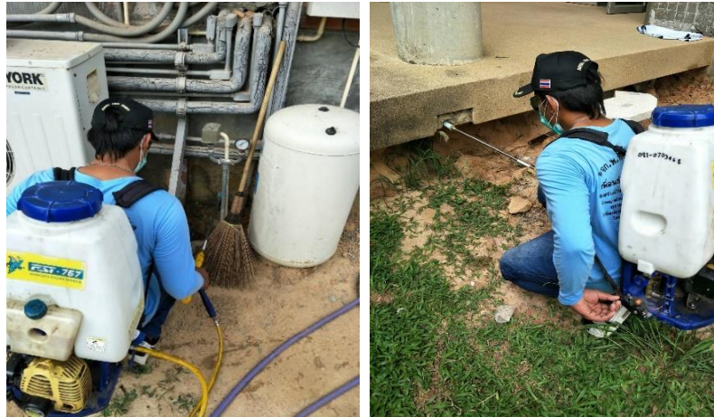
ภาพที่ 95 กำจัดปลวกโดยวิธีอัดสารเคมีลงพื้นภายในอาคาร
