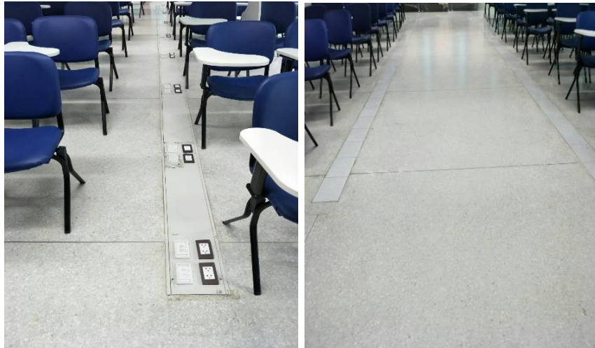
ภาพที่ 96 ปิดรางไฟเพื่อความปลอดภัยของผู้ใช้ห้องเรียน
