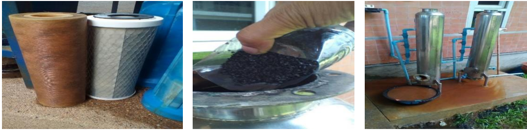
ภาพที่ 93 เปลี่ยนถ่านสารเรซินและสารคาร์บอนทุกๆ 6 เดือน และเปลี่ยนไส้กรองคาร์บอนทุก 3 เดือน
