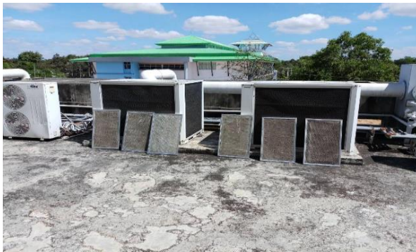
ภาพที่ 104 ล้างทำความสะอาดเครื่องปรับอากาศ (ปีละ1ครั้ง)
