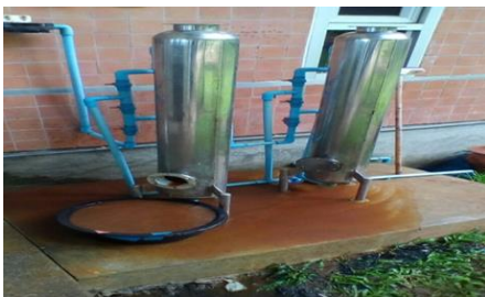
ภาพที่ 101 ดูแลระบบน้ำ โดยการเปลี่ยนไส้กรองคาร์บอนทุก 3 เดือน ซึ่งต้องมีการเปลี่ยนถ่ายสารเรซินและสารคาร์บอนทุกปี (ปีละ 1 ครั้ง)
