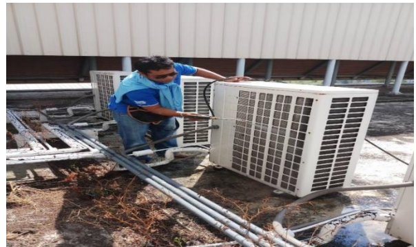
ภาพที่ 104 ล้างทำความสะอาดเครื่องปรับอากาศ (ปีละ1ครั้ง)
