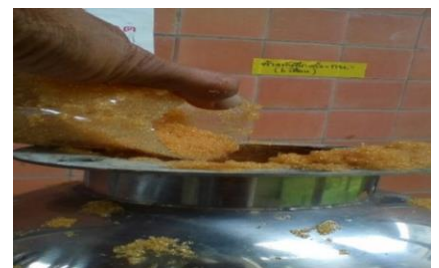
ภาพที่ 101 ดูแลระบบน้ำ โดยการเปลี่ยนไส้กรองคาร์บอนทุก 3 เดือน ซึ่งต้องมีการเปลี่ยนถ่ายสารเรซินและสารคาร์บอนทุกปี (ปีละ 1 ครั้ง)
